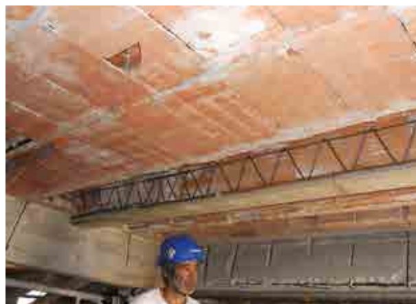
Traliccio di 3 m, altezza 120 mm
