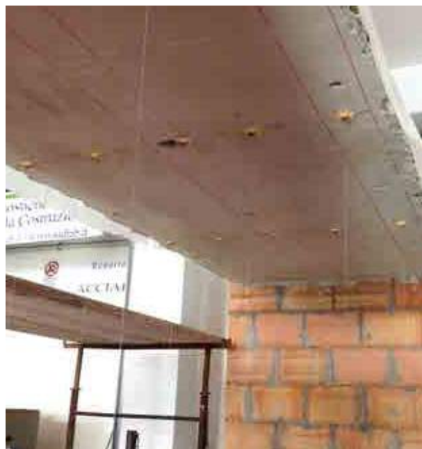
Preparazione del solaio alla prova di carico presso il Laboratorio SidLab .
