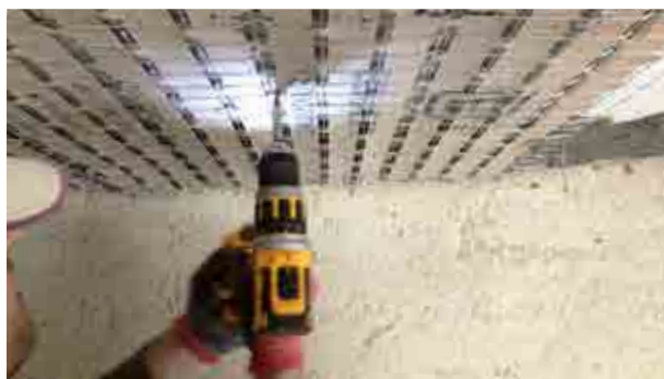
5) Avvitamento del tassello Stucanet per il sicuro fissaggio del pannello Stucanet al supporto.
