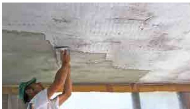
6) Applicazione della malta da intonaco Plasterwall nello spessore di 2 cm (stesa in due mani da 1 cm ciascuna).
