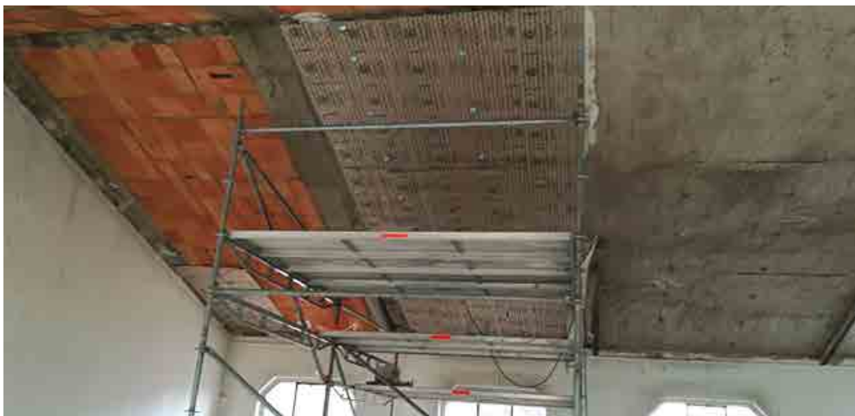
Sistema X Plaster in fase di applicazione.
