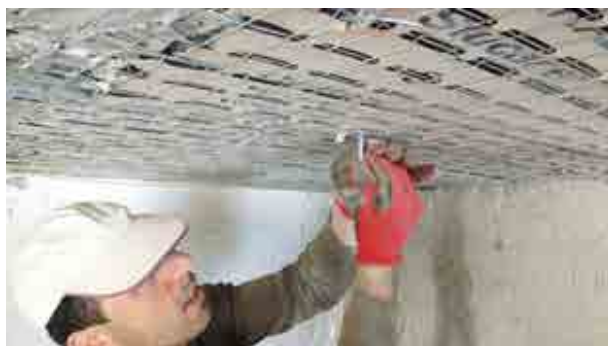
3) Esecuzione del foro per l'inserimento del tassello Stucanet.
