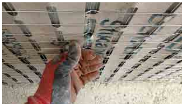
4) Posizionamento del tassello Stucanet.
