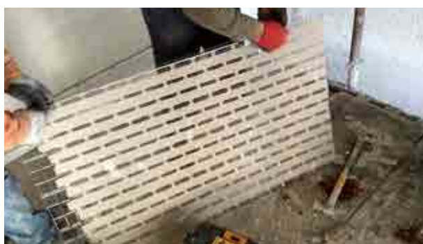
1) Preparazione del pannello Stucanet (vedere approfondimento specifico a pag. 113) ed eventuale taglio a misura.
