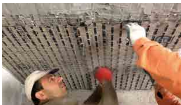
2) Posizionamento a soffitto del pannello Stucanet.
