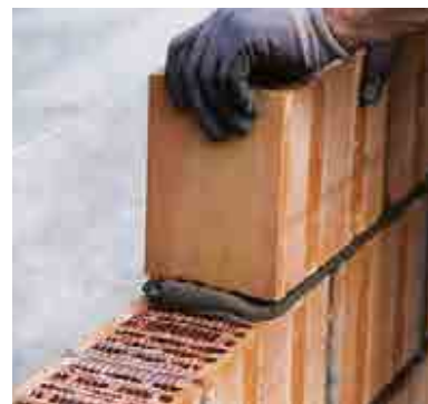
Posa del corso successivo di blocchi.
