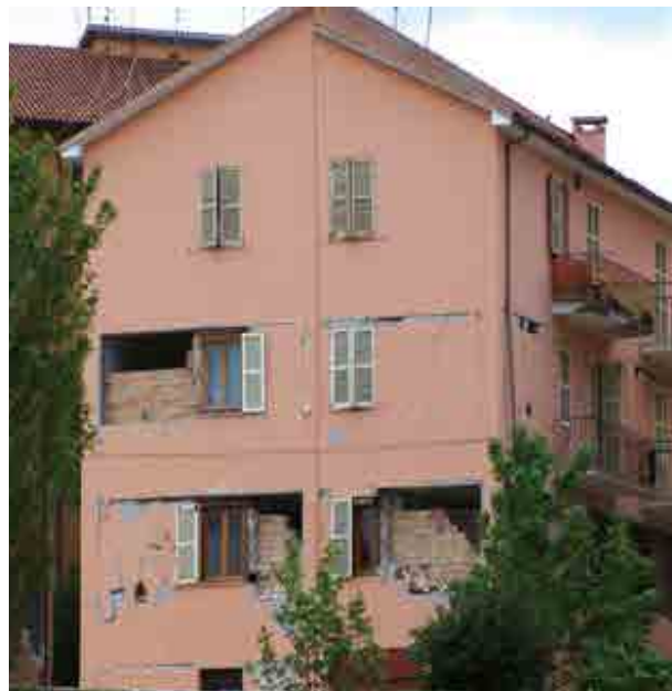
Pareti di tamponamento danneggiate in seguito al sisma dell'Aquila del 2009.
