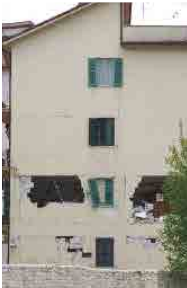
Pareti di tamponamento danneggiate in seguito al sisma dell'Aquila del 2009.
